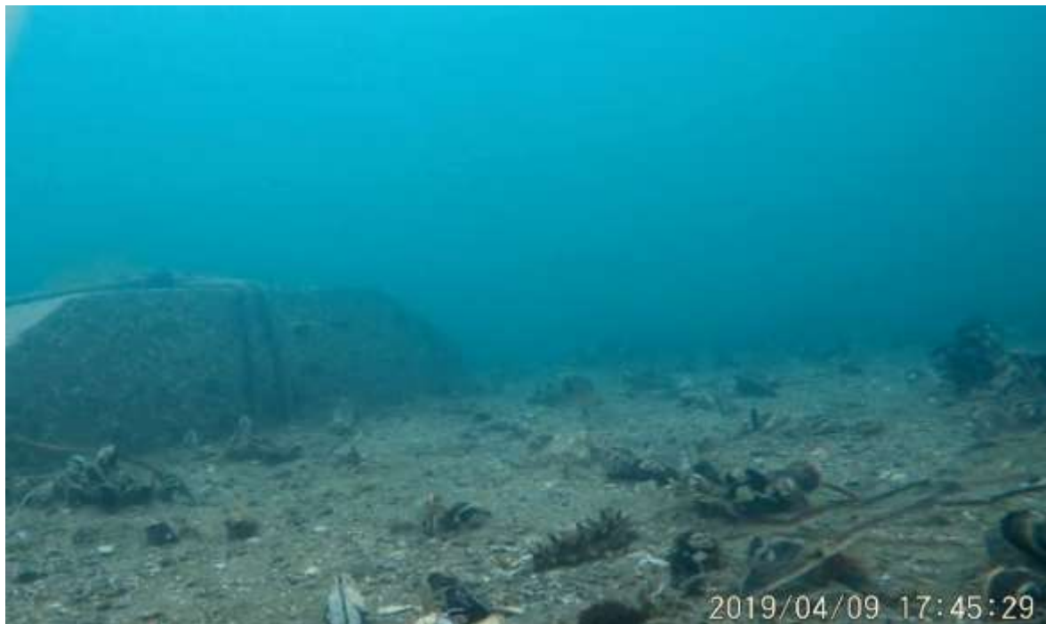
Рисунок 9. Бетонные блоки в переходном поясе у северо-западного выходного мыса бухты
