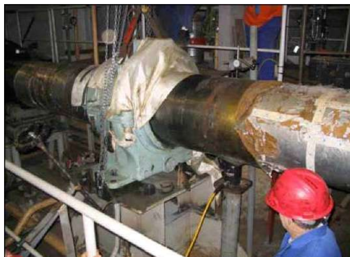
Рис. 2. Определение нагрузки на подшипник валопровода способом поддомкрачивания вала
